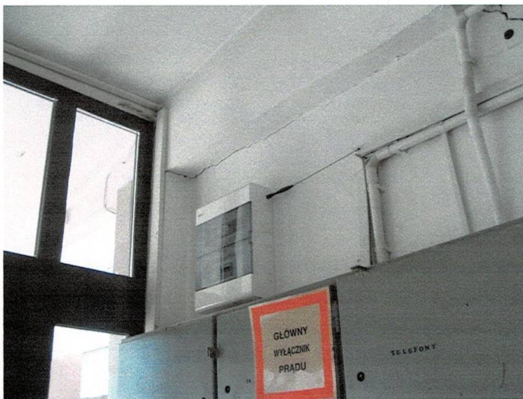
Fot. 10 - Wnętrze wiatrołapu - zarysowanie poziome, ujawnione wzdłuż żebra bocznego usztywniającego płytę zadaszającą nad wejściem (nad skrzynkami instalacji elektrycznej zlokalizowanymi w przedsionku)
