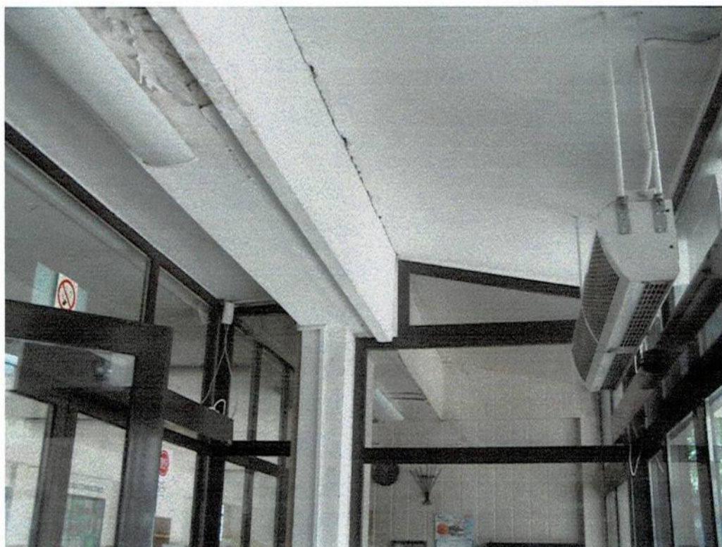
Fot. 8 - Wnętrze wiatrołapu - widoczne pęknięcie poziome na styku konstrukcji zadaszenia nad wejściem (strona prawa patrząc od pęknięcia) i podciągu podpierającego ścianę zewnętrzną budynku wyższych kondygnacji (po lewej); po bokach widoczne przeszklone ścianki wiatrołapu (z prawej - od strony wejścia, z lewej - od strony holu); w głębi pomieszczenie portierni
