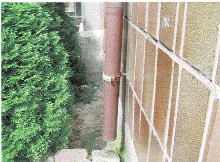
Fot. 5 - Widok na instalację odprowadzania wód opadowych z daszku nad wejściem do budynku - zbliżenie na dolny fragment rury spustowej pokazanej na fot. nr 4
