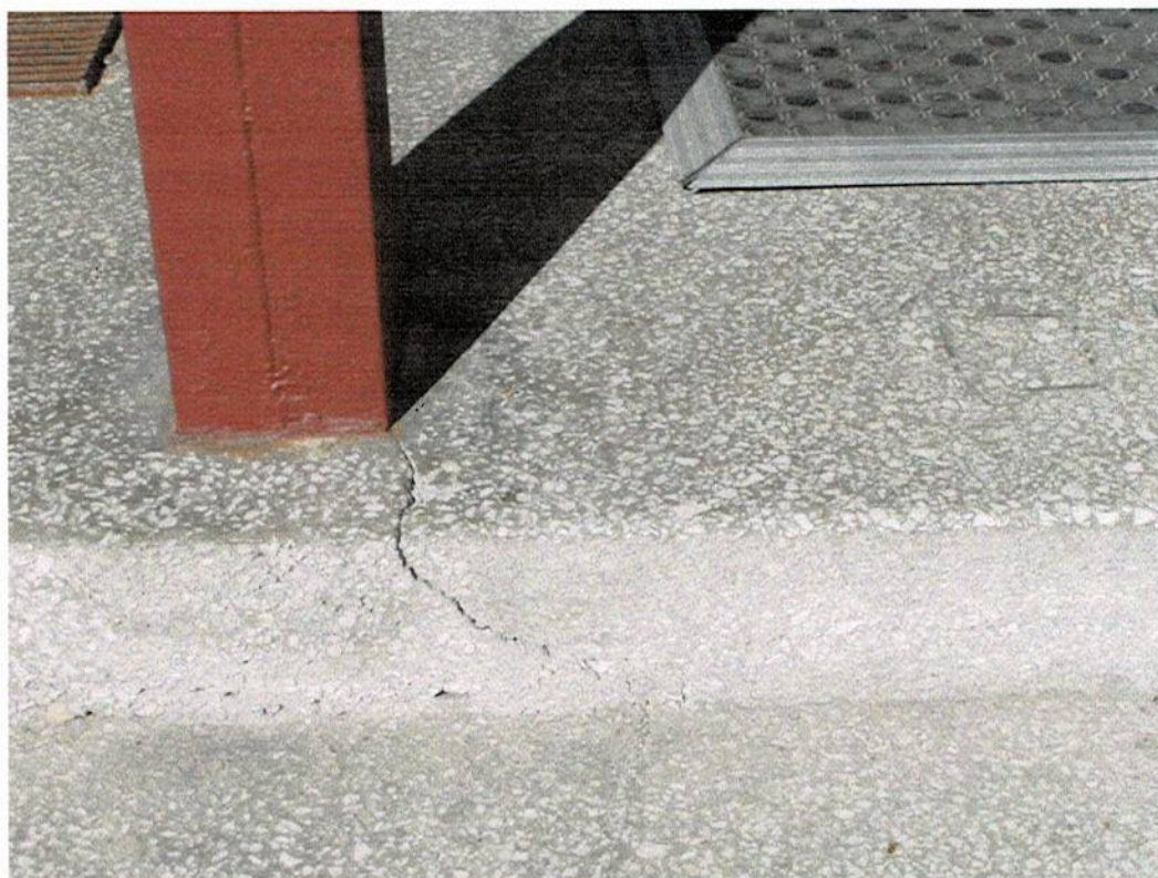
Fot. 13 - Płyta podestu wejściowego - widoczne pęknięcia w rejonie podstawy słupa środkowego od strony lewej (zbliżenie)
