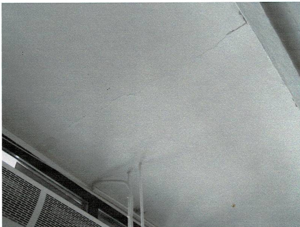
Fot. 11 - Wnętrze wiatrołapu - zarysowanie ujawnione na spodzie płyty zadaszenia wzdłuż osi wejścia do budynku
