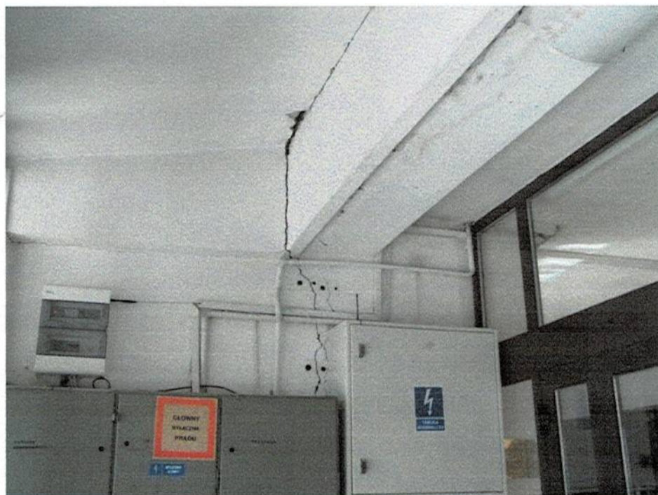
Fot. 6 - Wnętrze wiatrołapu - widoczne pionowe pęknięcie zewnętrznej ściany przedsionka na styku elementów konstrukcji nośnej znajdującej się pod zadaszeniem wejścia (strona lewa patrząc od pęknięcia) oraz znajdującej się w obrysie bryły głównej budynku (strona prawa) z widocznym podciągami podpierającym ścianę zewnętrzną budynku wyższych kondygnacji
