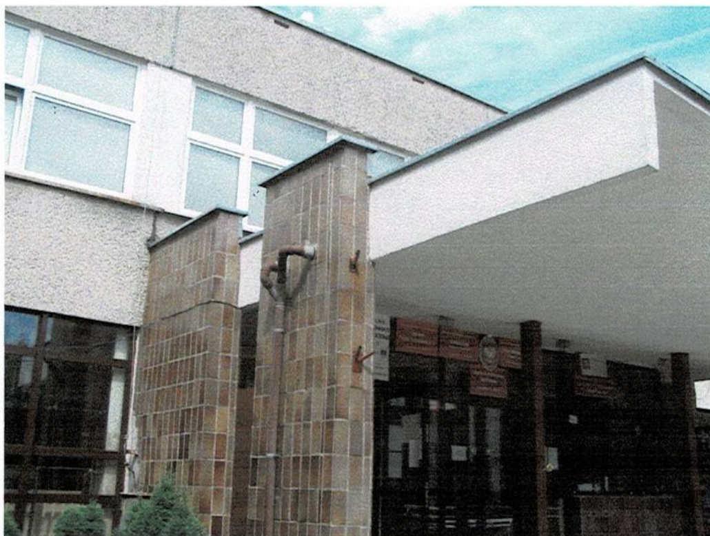
Fot. 3 - Widok na instalację odprowadzania wód opadowych z daszku nad wejściem do budynku (lewa strona wejścia patrząc od frontu)
