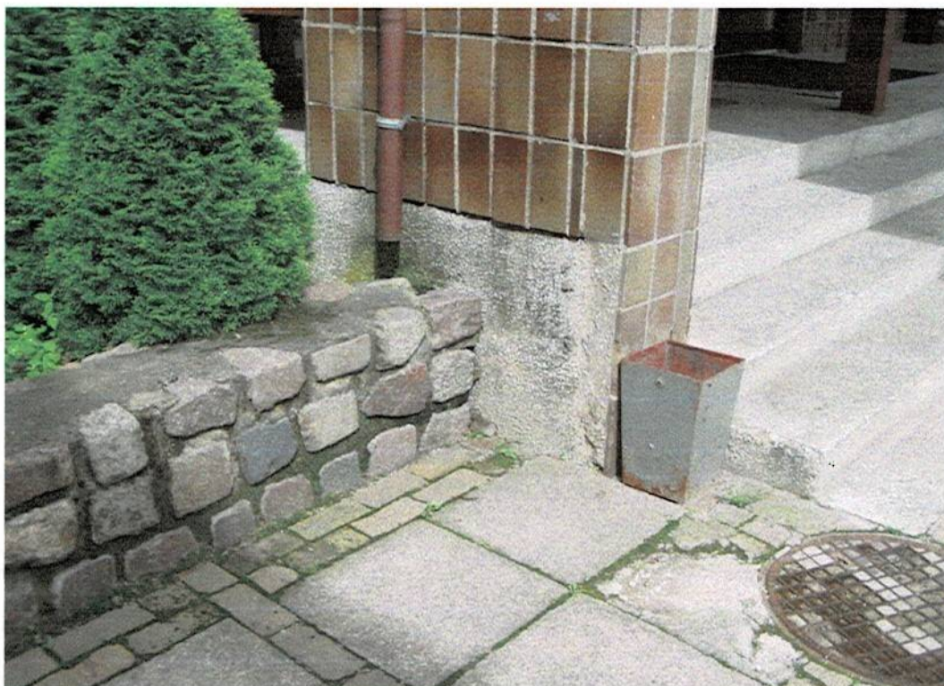
Fot. 4 - Widok na instalację odprowadzania wód opadowych z daszku nad wejściem do budynku - dolny fragment rury spustowej instalacji deszczowej odprowadzający wody opadowe na teren bezpośrednio przyległy do ściany bocznej wejścia
