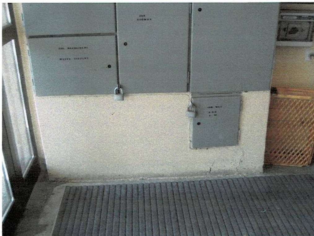
Fot. 9 - Wnętrze wiatrołapu - zarysowanie pionowe, ujawnione na ścianie bocznej wiatrołapu (przy skrzynkach energetycznych), biegnące od posadzki i rozszerzające się ku górze
