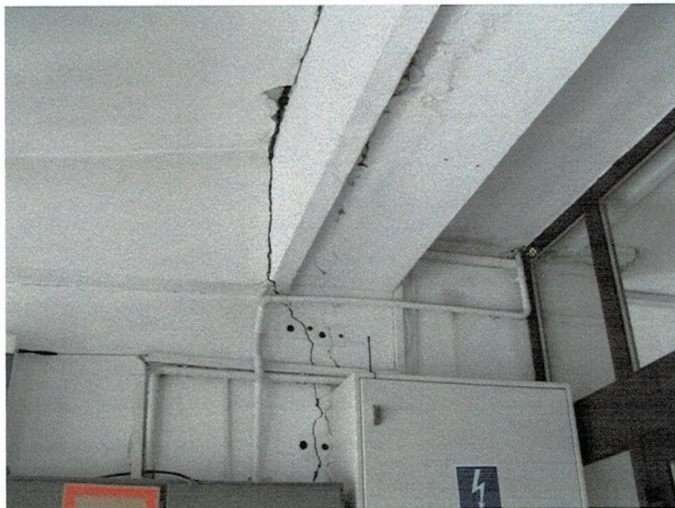
Fot. 14 - Wnętrze wiatrołapu - strefa z szafkami elektrycznymi, ponad szafkami widoczne szklane płytki kontrolne (stare) założone w celu monitorowania stanu uszkodzeń
