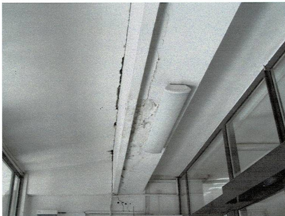
Fot. 7 - Wnętrze wiatrołapu - widoczne pęknięcie poziome na styku konstrukcji zadaszenia nad wejściem (strona lewa patrząc od pęknięcia) i podciągu podpierającego ścianę zewnętrzną budynku wyższych kondygnacji (po prawej); po bokach widoczne przeszklone ścianki wiatrołapu (z lewej - od strony wejścia, z prawej - od strony holu)
